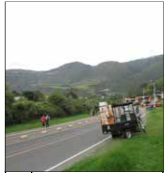
4 Autopista laguna de Yawarcocha
