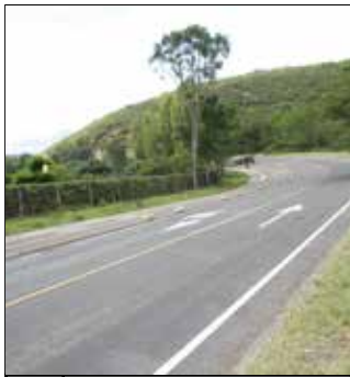
9 Autopista laguna de Yawarcocha
