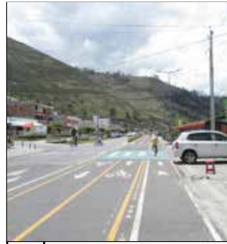
7 Autopista laguna de Yawarcocha
