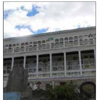
4 Sector central del Cementerio
