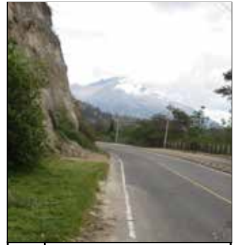
8 Autopista laguna de Yawarcocha
