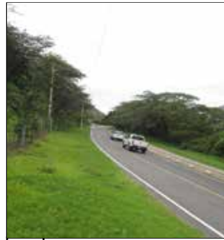
3 Autopista laguna de Yawarcocha
