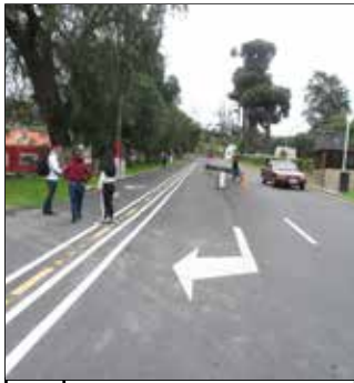
1 Autopista laguna de Yawarcocha
