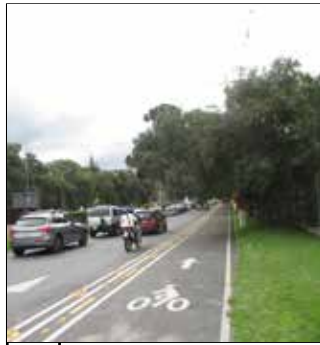
2 Autopista laguna de Yawarcocha
