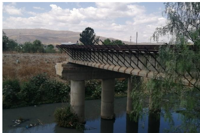
Fig. 1. Vista del puente Concordia abandonado
