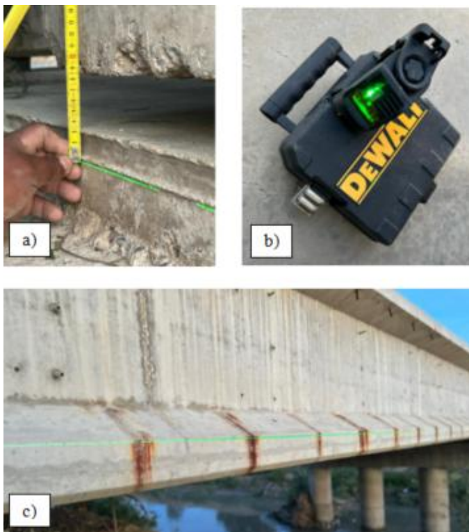
Fig. 6. Nivelación láser: a) Medición de desnivel, b) Equipo de nivelación, c) Vista de la luz del láser sobre viga
