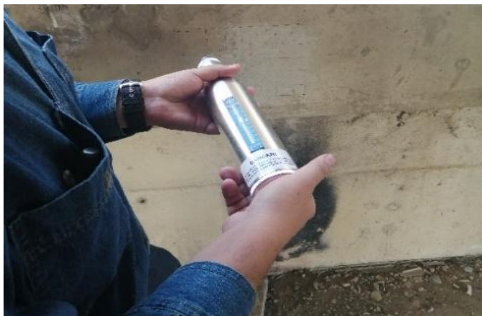
Fig. 3. Ensayo de esclerometría ASTM C805-18
