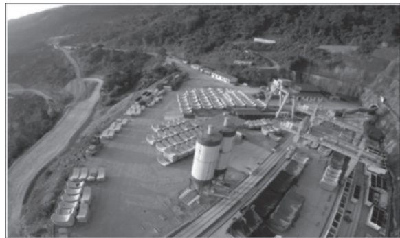
Figura 6. Instalaciones hidroeléctricas en Ecuador.
