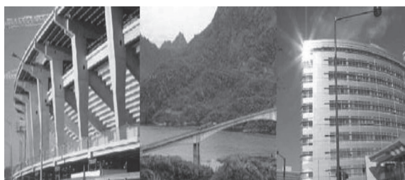
Figura 4. Construcciones realizadas con concreto de alta resistencia.
