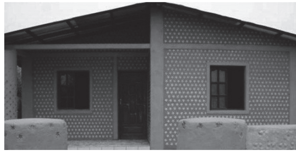
Fotografía 1. Vivienda construida con ladrillos tipo PET.
