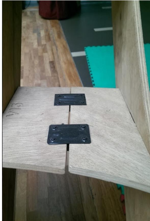
Figura 5. Ensamble de los módulos de la estructura
