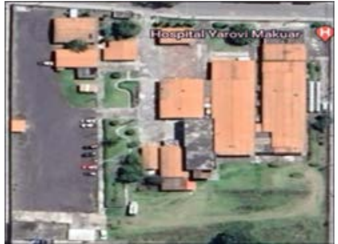
Figura 7. Vista aérea del Hospital Básico Yerovi Mackuart
