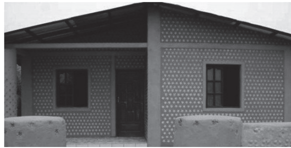
Fotografía 1. Vivienda construida con ladrillos tipo PET.
