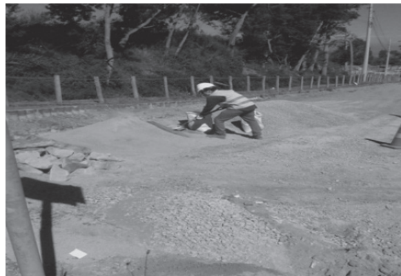
Figura 2. Extracción del agregado fino de la cantera Pifo.
