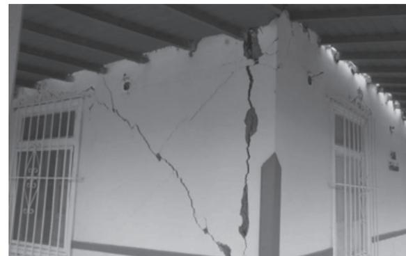
**Figura 9.** Daños en muros de adobe por esfuerzos sísmicos [16].
