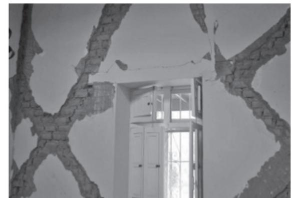
**Figura 10.** Daños en muros de adobe por esfuerzos sísmicos [16].
