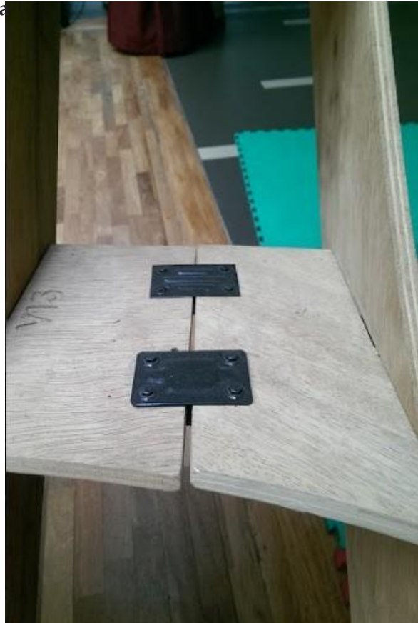
Figura 5. Ensamble de los módulos de la estructura
