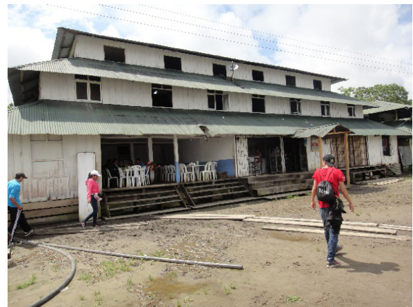
Figura 16. Piso de viviendas sobre elevadas para evitar la inundación de agua y sedimentos
