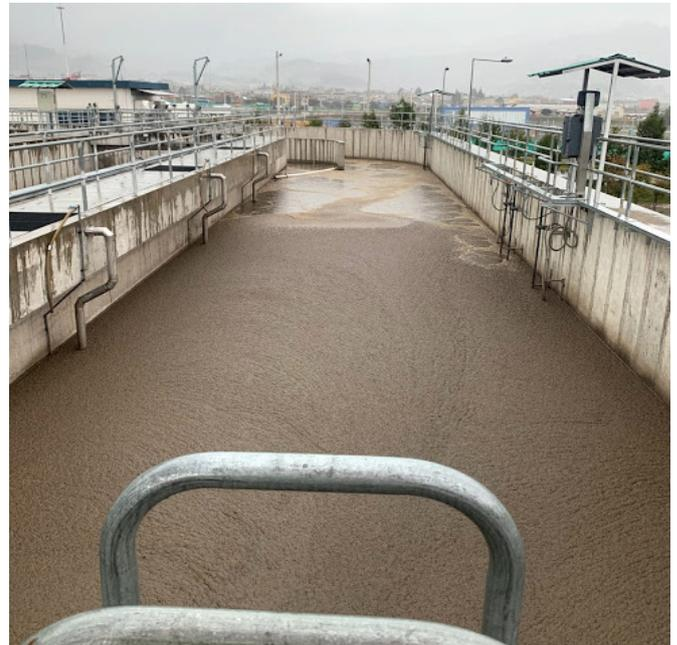
Figura 3. Presencia de espumas en el reactor biológico.
