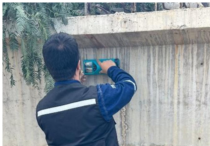
Fig. 4. Aplicación del pachómetro en viga postensada
