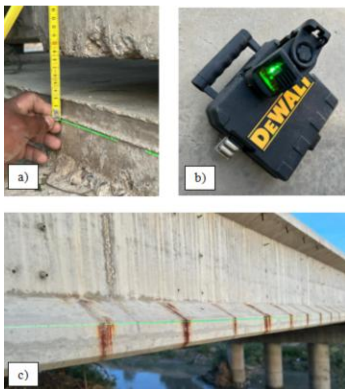
Fig. 6. Nivelación láser: a) Medición de desnivel, b) Equipo de nivelación, c) Vista de la luz del láser sobre viga
