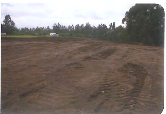
Foto 2. Áreas en proceso de relleno con una pendiente muy pronunciada que debería ser nivelada formando terrazas (Espinoza y Cáceres, 2014)
