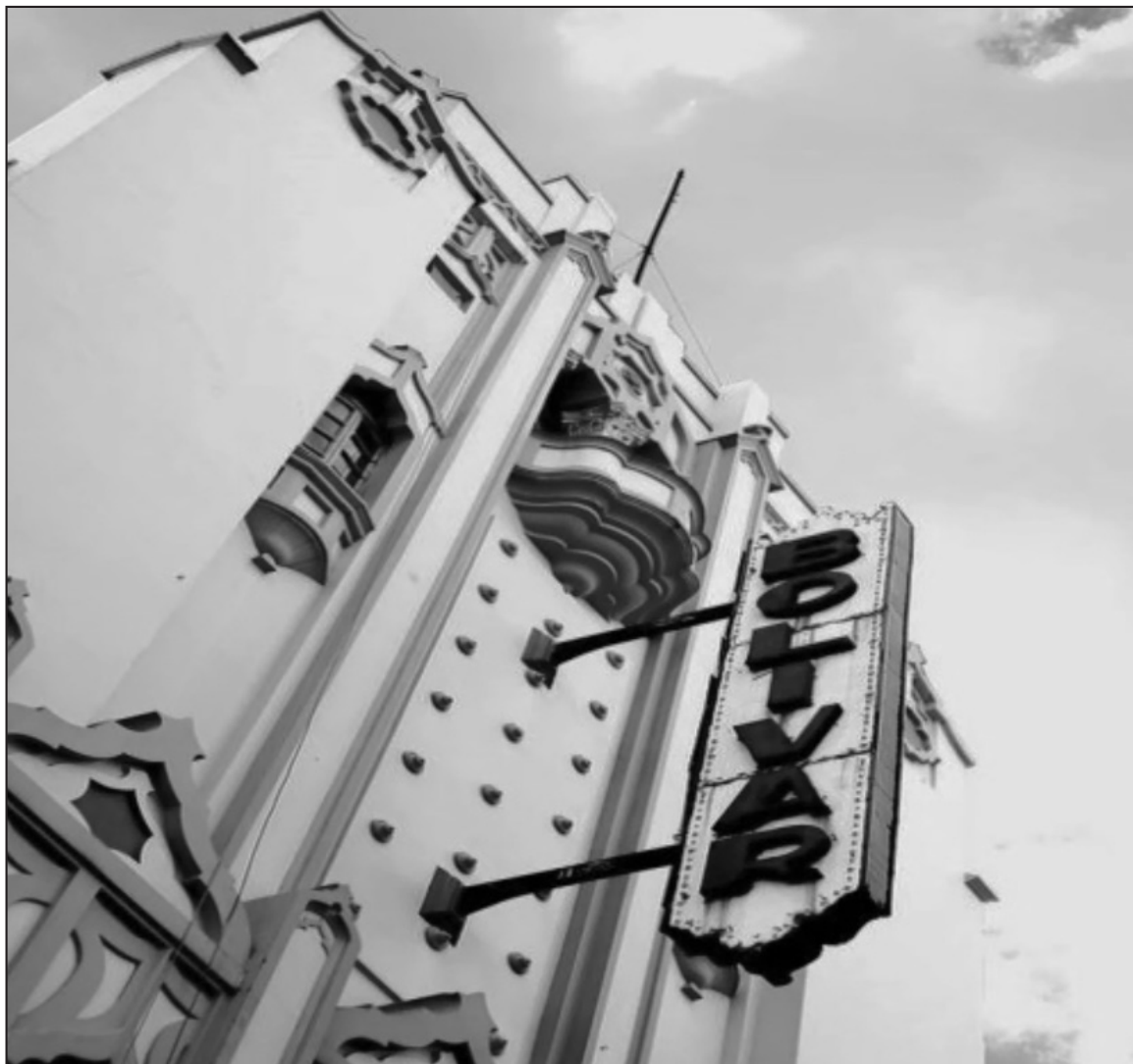
Figura 3. Fachada del Teatro Bolívar. Fuente: Quito Nostálgico.
