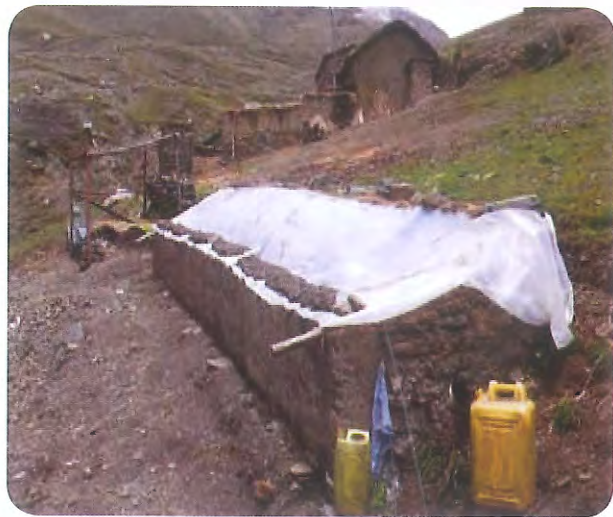
Foto 2 Biodigester para el caso de páramos (a) y para el caso de ambiente tropical (b).
