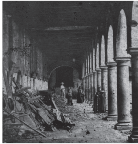
Foto 1. Claustro principal de San Francisco, detalle de los deterioros producidos por el terremoto de 1868. Fuente: Archivo Nacional de Fotografía (INPC, 2015).
