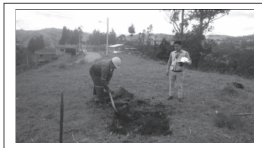
Figura 1. Apertura de calicatas.
