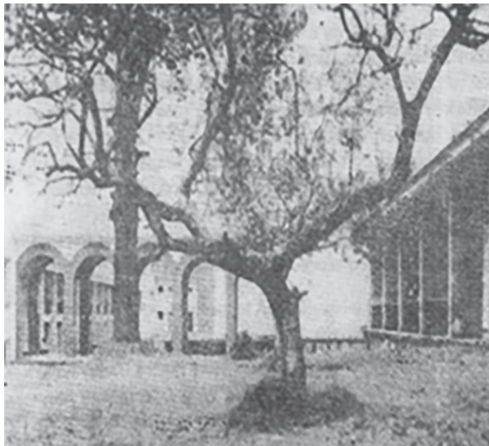
Imagen 2. Primeras instalaciones FAU-UCE Fuente: Revista AyS n.º12, 1997.
