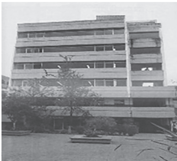
Imagen 7. Edificio de talleres FAU Fuente: Revista AyS n.º 18, 2013.
