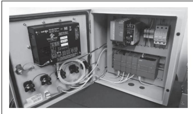
*Figura 22.* Parte interior del tablero de control.
