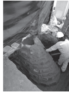
Ducto de ventilación sobre las criptas que están detrás de la capilla de la Virgen del Pilar (cateo 1)
