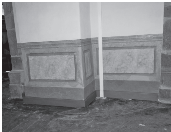
Después de la intervención
