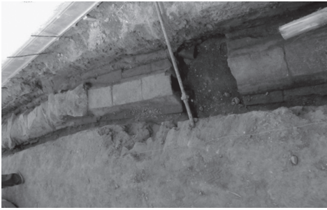
Canales de aguas lluvia (trinchera 1)
