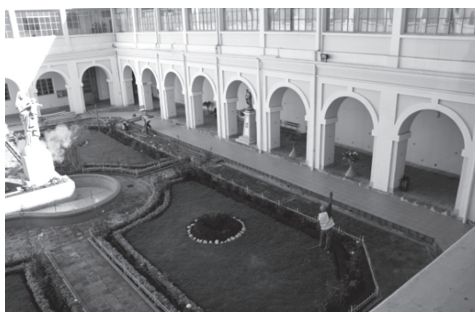
Convento de San Carlos frente de intervención
