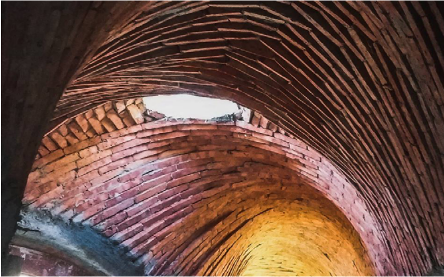
FIGURA 1. Fuente: Fabio Mendes. Techo de la Vivienda "Gureetxea", El Hoyo, Chubut. Estructura abovedada alabeada inspirada en las estructuras de los cascarones de la naturaleza.
