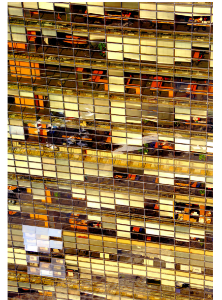
Imagen 1. Fachada original Edif. "Carlos Pellegrini", Unión Industrial Argentina (UIA). Fuente: Pablo Corral 2021
