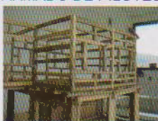
ARMADO DE ESQUELETO DE LA VIVIENDA
