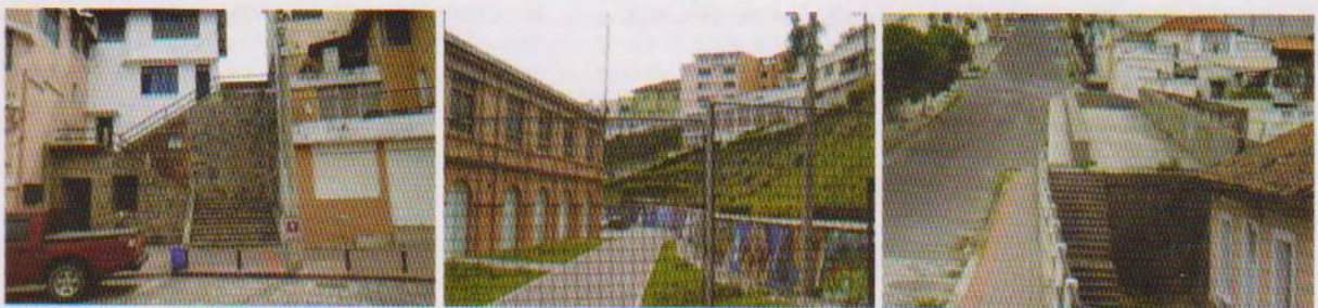
LAS FOTOGRAFÍAS 1, 2 Y 3 DEMUESTRAN LA FALTA DE ACCESIBILIDAD Y DIFICULTADES DE MOVILIDAD.
