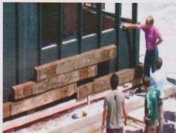
FIG. 2: COLOCACIÓN DE DURMIENTES.
