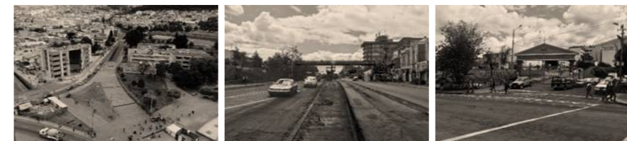
Figura 2. Puertas de entrada desde la Avenida América al Campus "Quito" de la Universidad Central del Ecuador, Quito. Fuente: Elaboración Propia.
