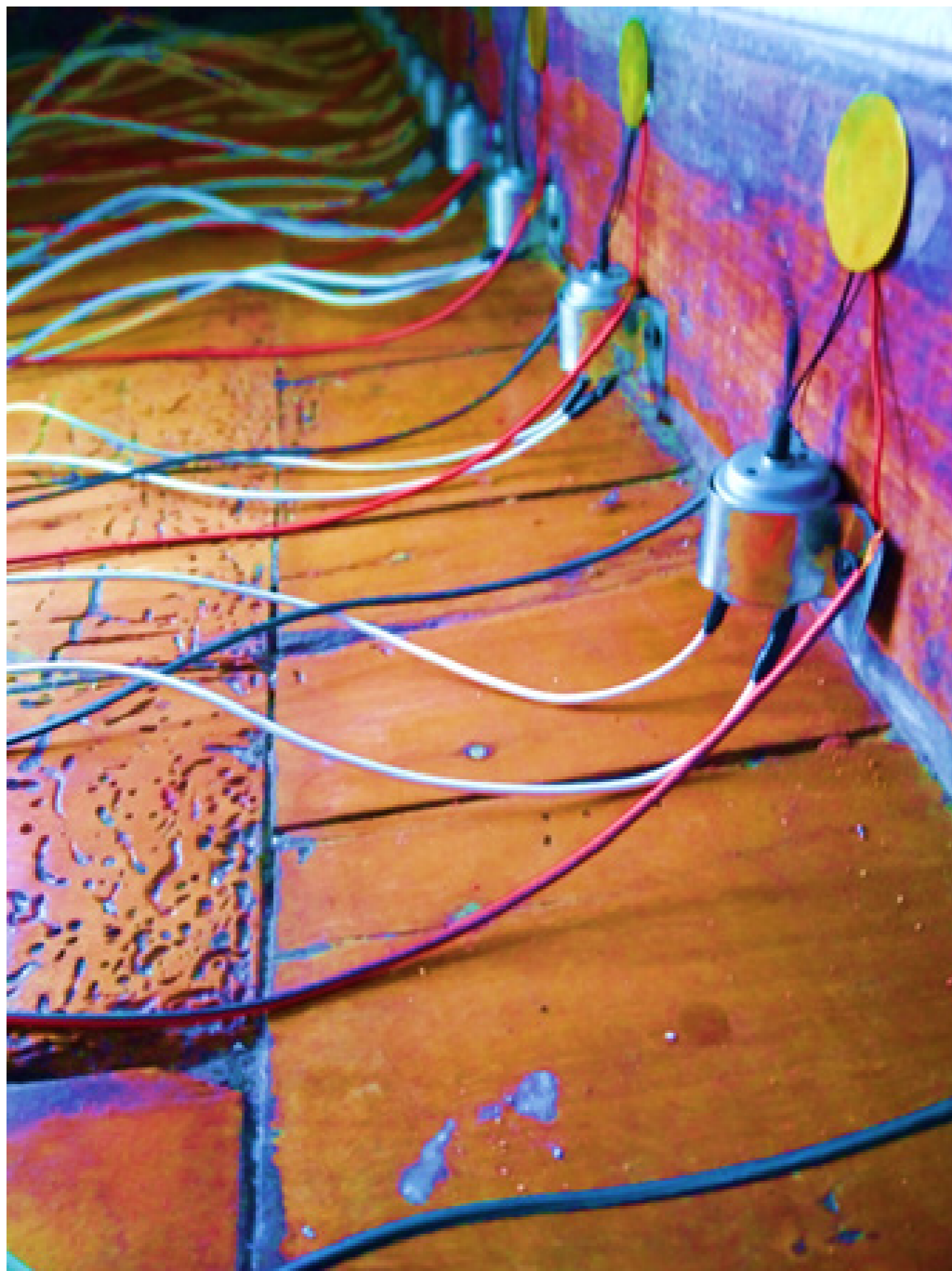
Imagen 4. Motores y sensores de contacto sobre superficie de madera, construcción de acople metálico para sujeción del motor y dispositivo para provocar fricción en la pared, Instalación Eco Visible
