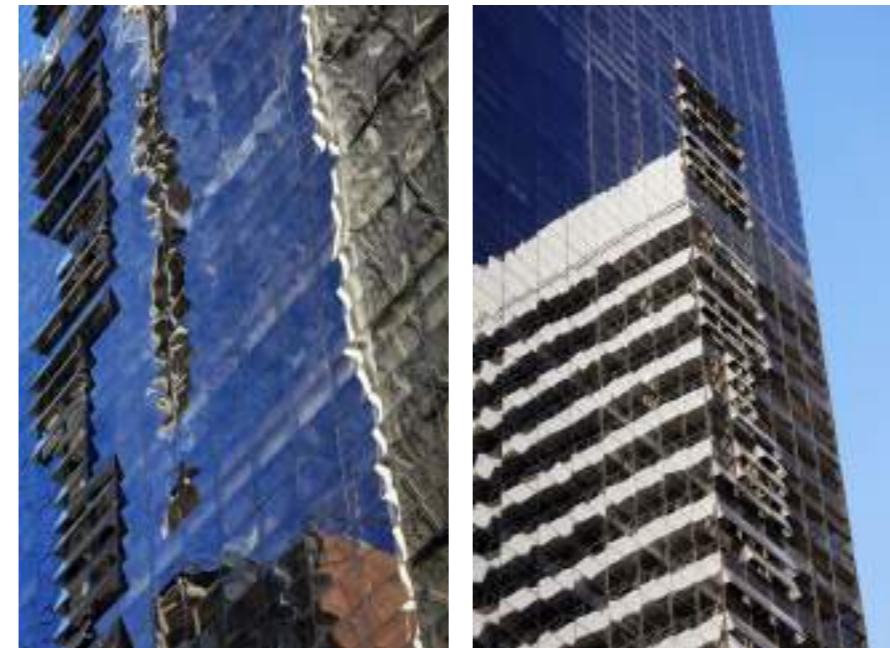
Imágenes 7 y 8. Fotografías transparencia y reflejo _ Nueva envolvente Edificio “Carlos Pellegrini” – Unión Industrial Argentina (UIA) Fuente: Pablo Corral 2021
