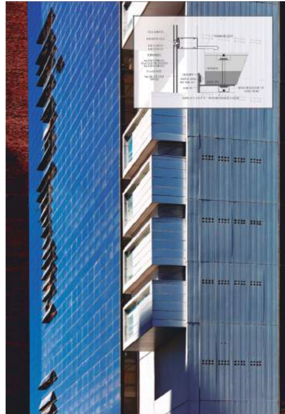
Imagen 6. Nueva envolvente para el Edif. "Carlos Pellegrini" – Unión Industrial Argentina (UIA). Fotografía y Detalle Const. Fuente: Pablo Corral 2021
